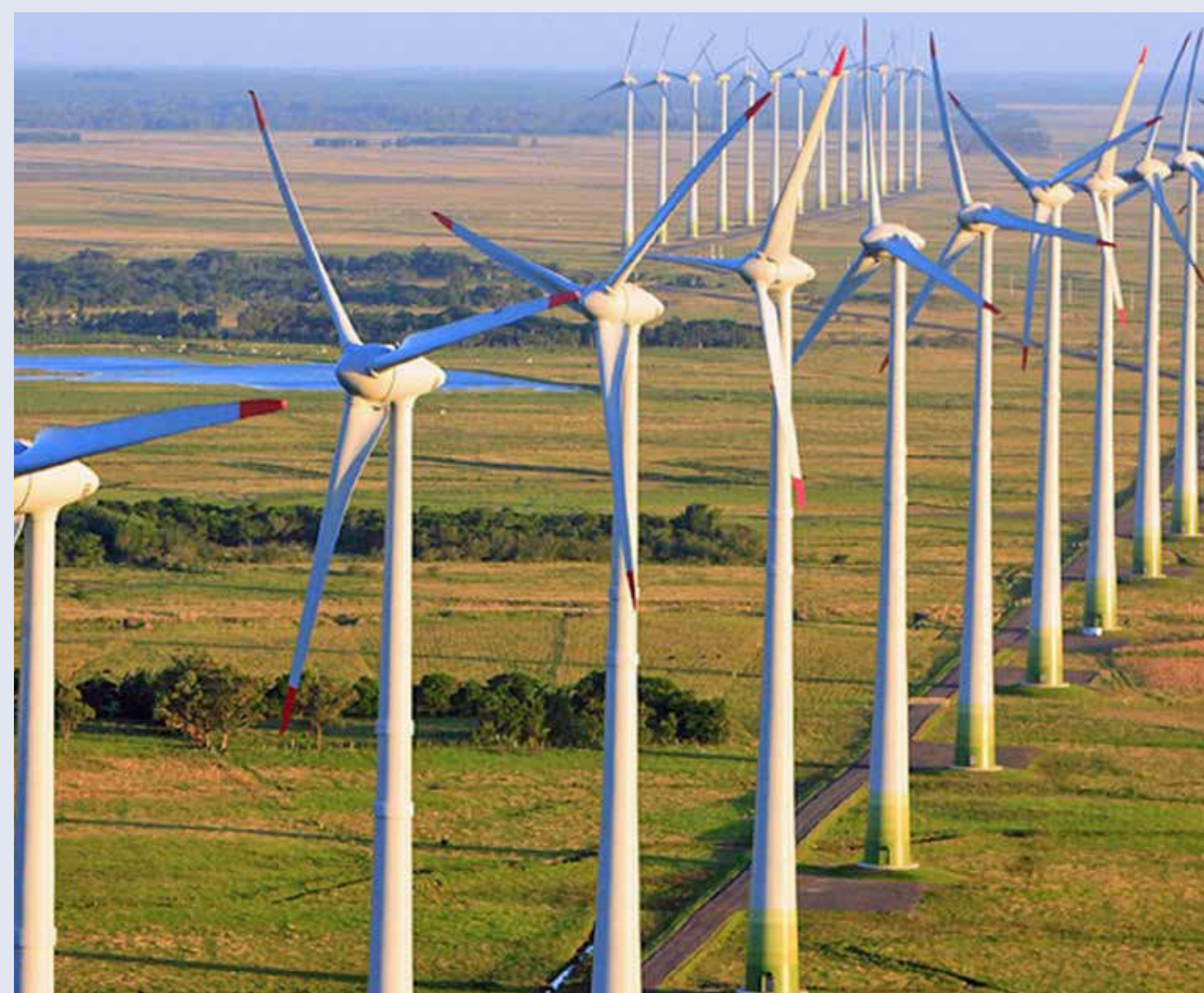
Torres de geradores eólicos
