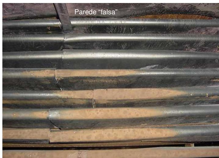
Figura 2.5: Erosão sobre as chapas dos dutos do trocador de calor no Economizador 1 (CGTEE – Candiota).
