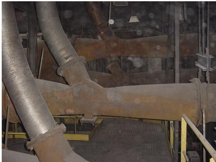
Figura 2.10: Ejtores durante a operação na Usina (CGTEE – Candiota).
