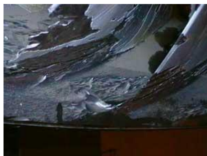
Desgaste por erosão em rotor
