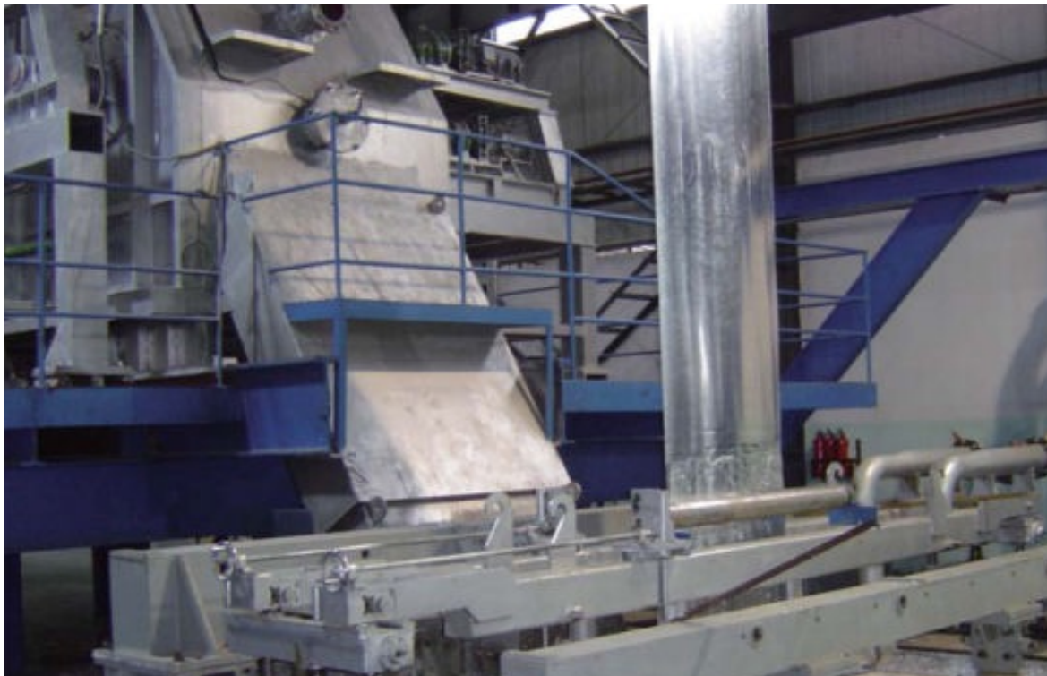
Fig 3. Linha de Galvanização Contínua [5,6]
